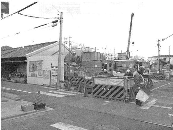
写真-2 φ 800mm 推進（発進立坑）施工状況
