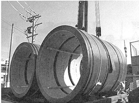
写真一六 φ 1,800mm 鋼・コンクリート管
