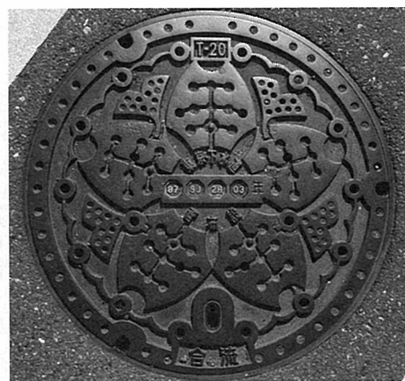
写真-3 東京都のマンホール蓋
