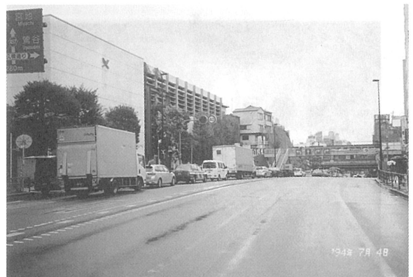
道灌山の切通し。正面を横切っているのが JR 西日暮里駅のホーム。左側の建物は私立の名門・開成高校
