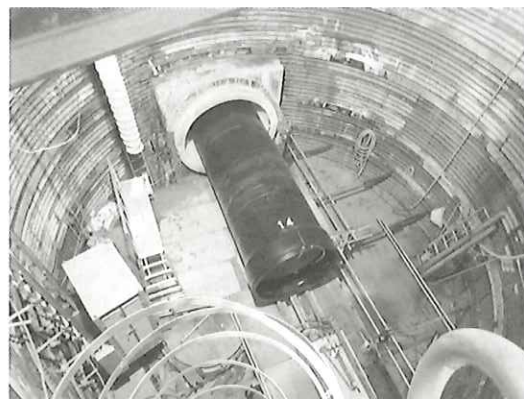
写真－２ 作業状況（発進立坑内）
