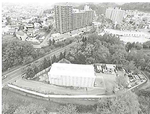
写真－１ 公園に設置した発進基地
