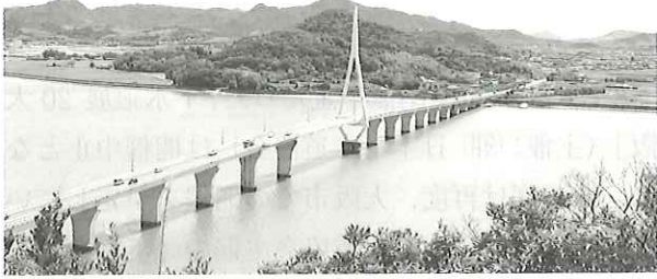
写真－7 山口湾に注ぐ榎野川河口部に架けられた全長 1,040 mの周防大橋
