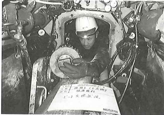
写真－8 ビット交換状況
