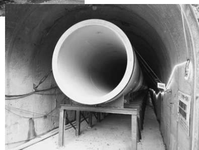
写真－10 推進管設置完了
