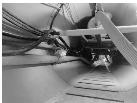
写真－4 推進管内下部空間確保
