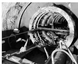
写真－7 推進機撤去
